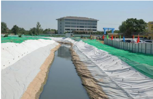
图 1 水利工程明渠导流施工
