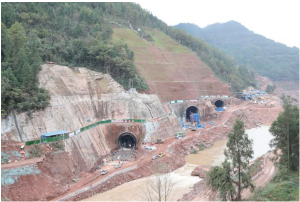
图 2 水利工程隧洞导流施工
