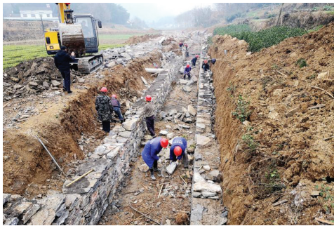
图1 浆砌石施工
